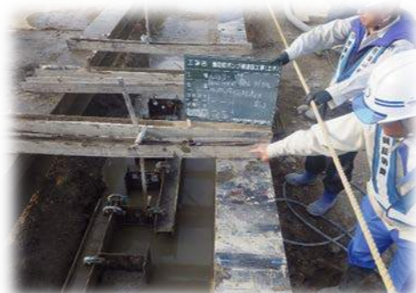
H29.11~H30.10 本体工事が本格的に始まり、地中連続壁工事で、土留壁を構築しました。この作業では、振動と騒音で周辺の皆様へご迷惑をおかけしました。
