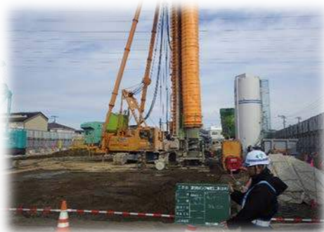
H29.11~H30.10 本体工事が本格的に始まり、地中連続壁工事で、土留壁を構築しました。この作業では、振動と騒音で周辺の皆様へご迷惑をおかけしました。
