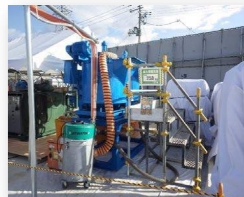
混練ミキサー(削孔、注入で使用するセメントミルクを練る機械です)
