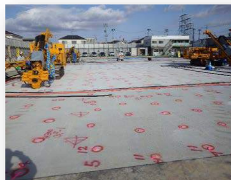
施工能率が上がるよう、施工面にはコンクリートを打設しました。いつもきれいな状態で施工できます。
