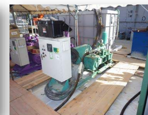
グラウトポンプ(ミキサーで練りあがったものをボーリングマシンへ送ります)
