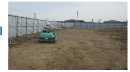
仮設通路づくり作業をしています。
