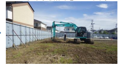
草刈・伐根作業をしています。
